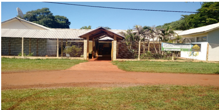
Figura 00 – Escola Rural Municipal São Dimas no Distrito de Bom Princípio do Oeste
